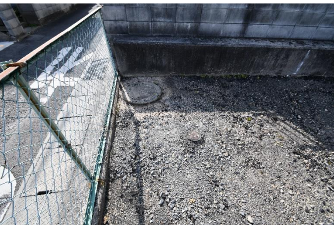
下水最終柵・ガス
